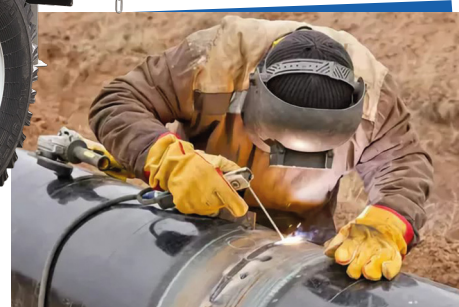
Корневой слой шва и горячий проход – CELLULOSE.
