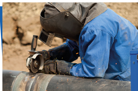
Подготовка кромок труб, зачистка швов, воздушно-дуговая строжка.
