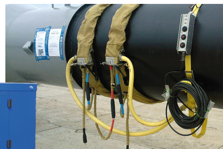
Предварительный подогрев кромок.
