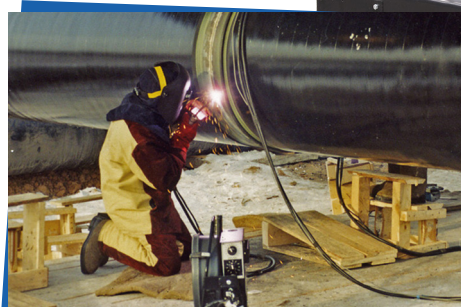
Заполняющие и облицовочный слои шва – FCAW.
